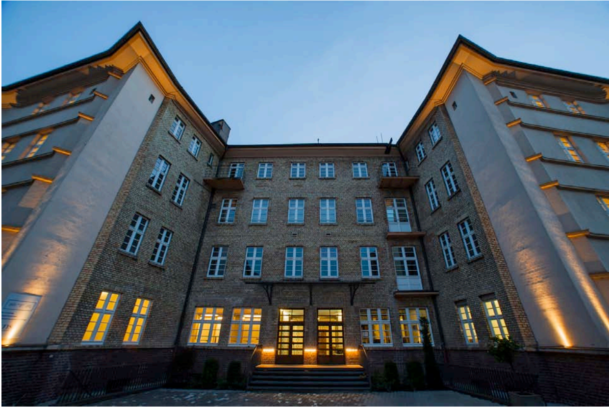
Hofseite des Gebäudes
