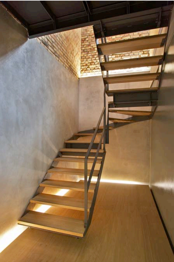
elementierte Treppe zu Rechenzentrum und Sanitärräumen
