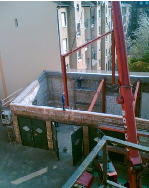
Einsetzen der Stahlbinder als Ersatz der gemauerten Trennwände zwischen den LKW-Garagen der Post – Bauzeit 2009
