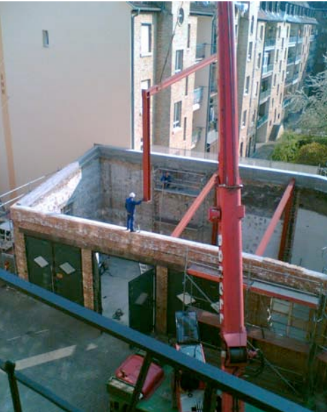
Einsetzen der Stahlbinder als Ersatz der gemauerten Trennwände zwischen den LKW-Garagen der Post – Bauzeit 2009
