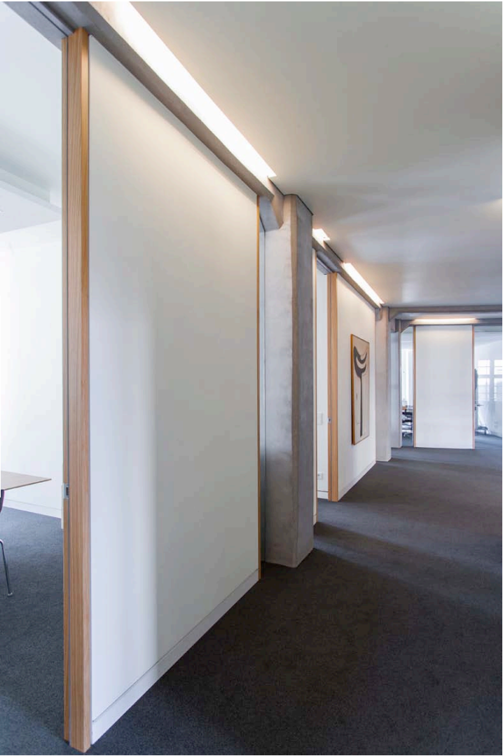
Büroflur mit freigelegtem, historischem Betontragwerk
