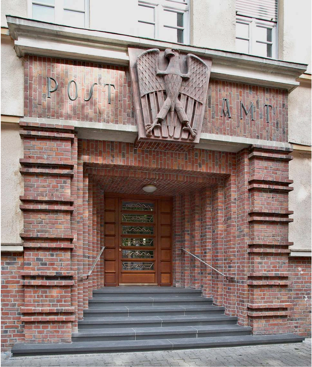
Denkmalgerecht sanierter Haupteingang – Türrekonstruktion
