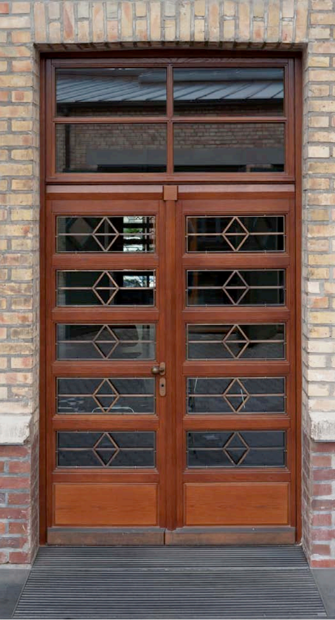
rekonstruierte Tür an der ehemaligen Laderampe
