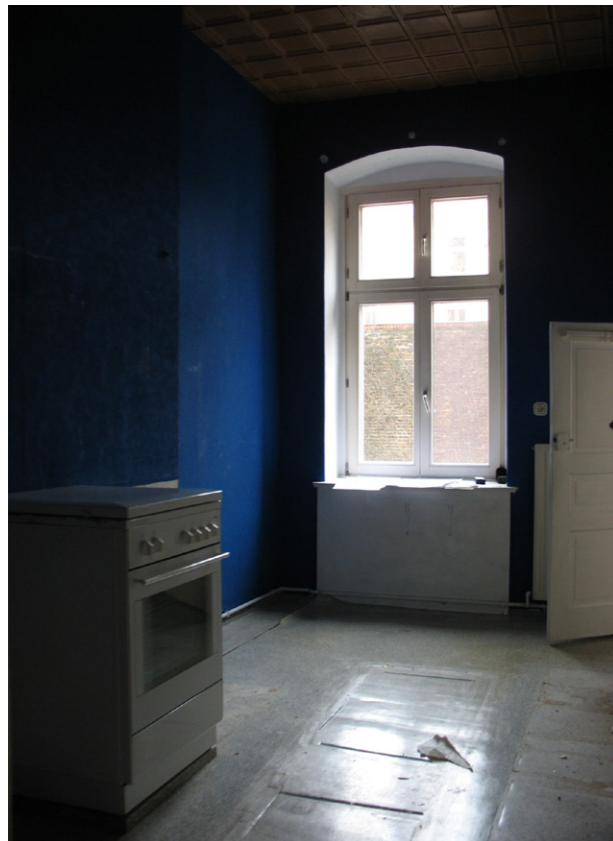
KÜCHE VOR UMBAU
