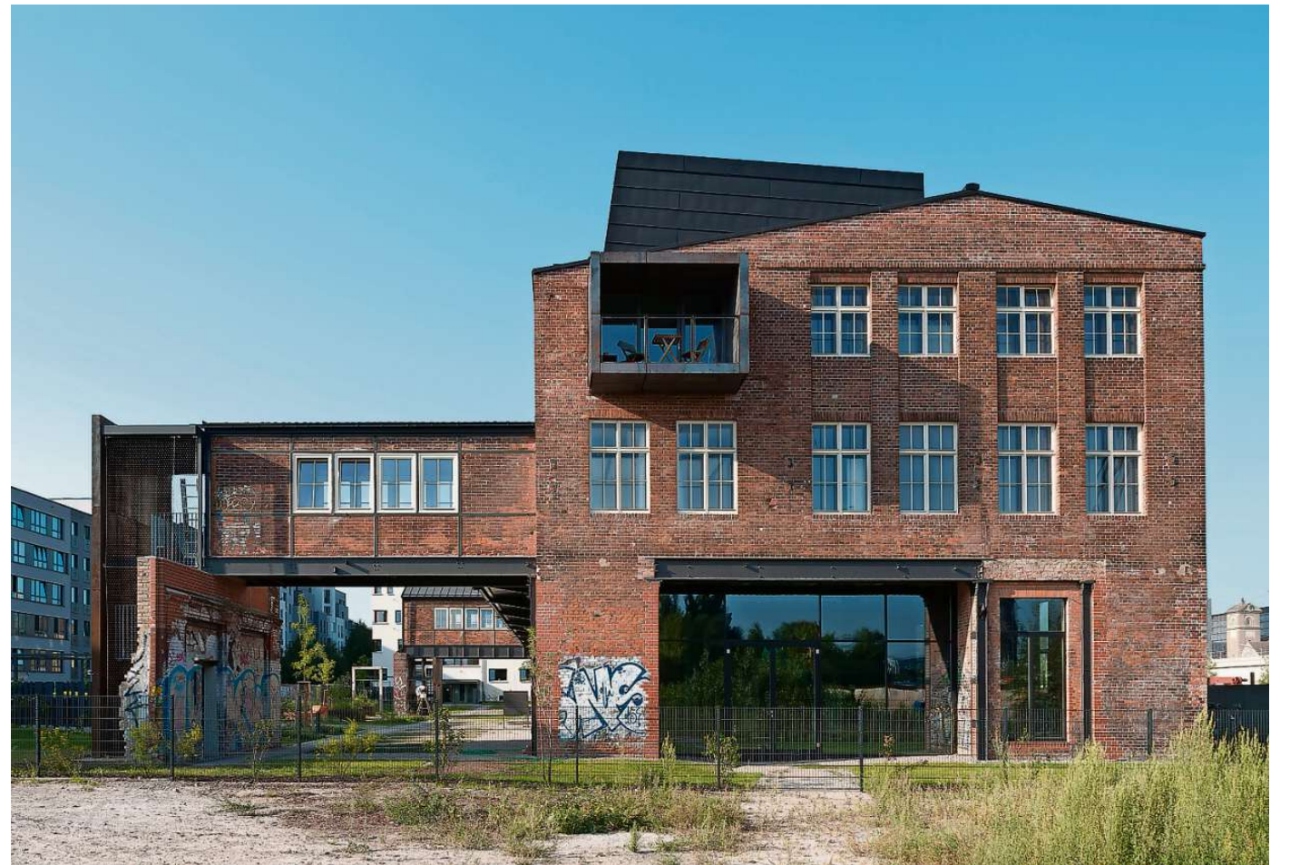
Der letzte Zug ist längst abgefahren. Das dreigeschossige Industrie- und Werkstattgebäude der Stralauer Glashütte ist rund 100 Jahre alt. Im Sanierungsprojekt wurde versucht, die Geschichte des Gebäudes mit einzubeziehen. Die alte Durchfahrt blieb erhalten. Fotos (2): Udo Meinel
